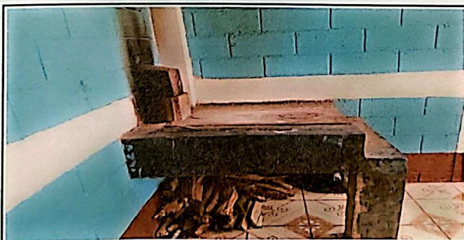
Foto 5: Plancha oxidada, quebrada y chimenea arruinada
