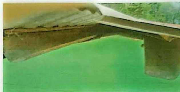
Foto 2: ESTRUCTURA DE TECHO
