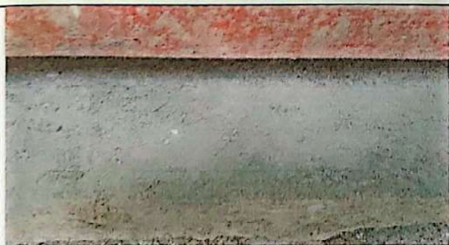
Foto 5: Sustitución de piso de granito
