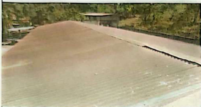
Foto 1: CUBIERTA DE LÁMINA
