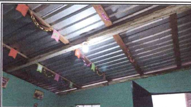
Foto 2: Estructura de techo de soporte de madera de un aula.
