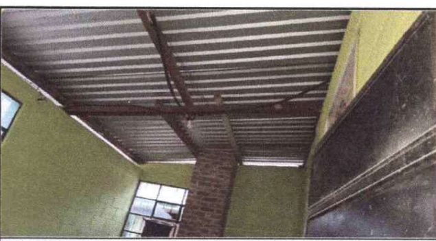
Foto 6: Estructura de techo de soporte de madera de la cocina.
