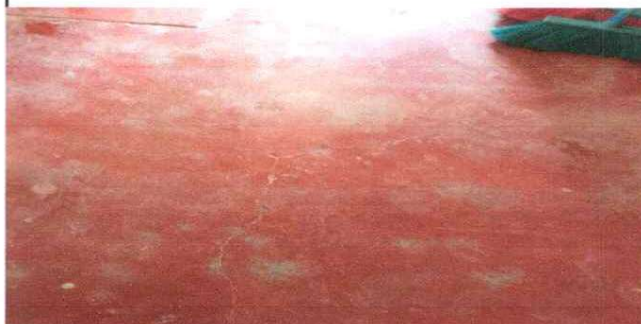
Foto 4. Sustrucción de piso de cemento líquido a piso de granito.
