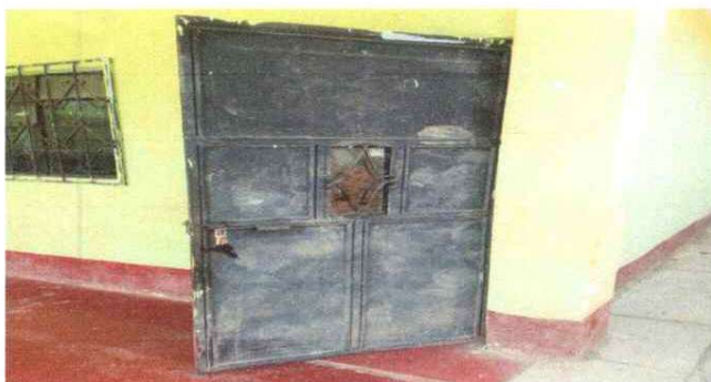
Foto 3. Sustrucción de puertas.
