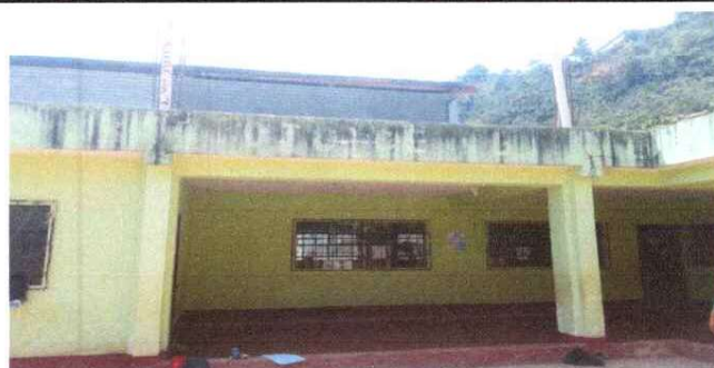
Foto 5. Pintura en muros exteriores e inferiores
