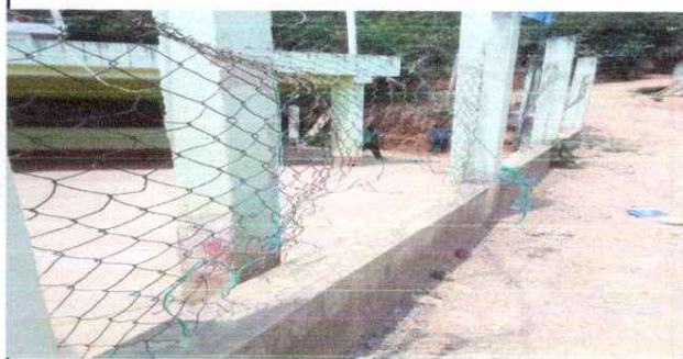
Foto 8. Reparacion de muro perimetral tubo hg y malla galvanizada.
