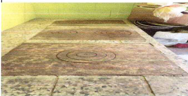
Foto 7: Sustrucción de planchas de metal..
