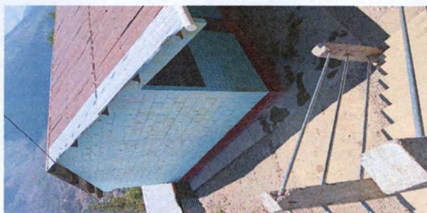
Foto 1: Sustrucción de capote de lámina para lámina troquelada
