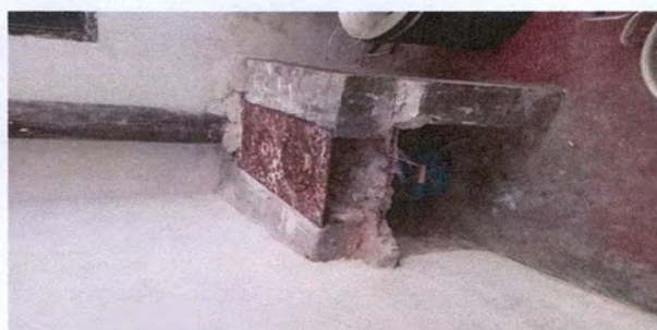
Foto 5: Sustrucción de plancha de 3 ornillos
