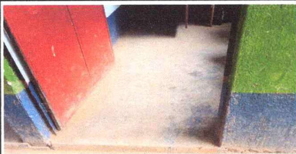
Foto 5: Sustrucción de puertas de metal
