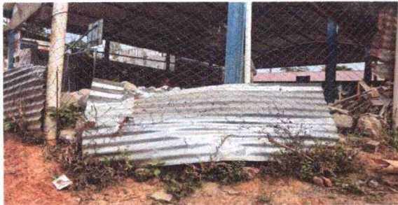
Foto 3: Sustrucción de malla de circulación
