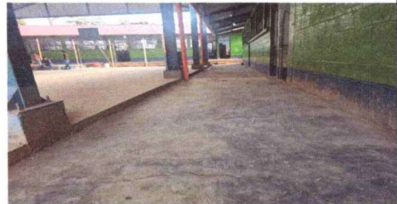
Foto 2: Sustrucción de piso por piso de granito en pasillo uno
