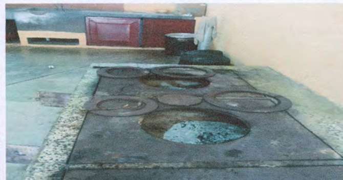
Foto 4: Sustrucción de estufa rural (Completa).
