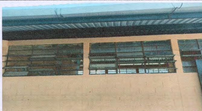
Foto 1: Sustrucción de estructura de metal de ventana.
