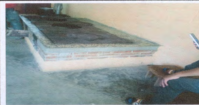
Foto 6: Instalación de azulejo en estufa rural.
