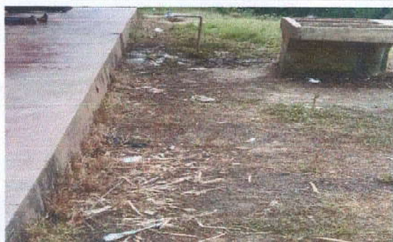
Foto 9: Mejoramiento de una banqueta de cemento en la pestaña del corredor y torta de cemento para la pila
