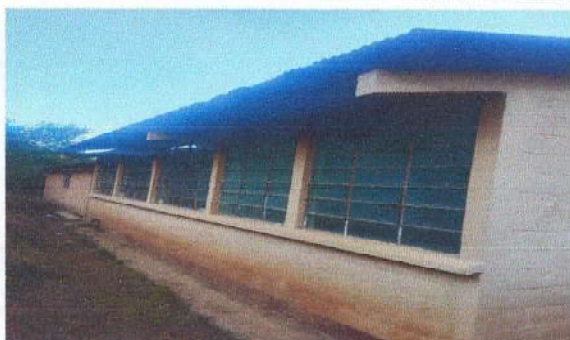
Foto 7: Fabricación e instalación de balcones de hierro en ventanas
