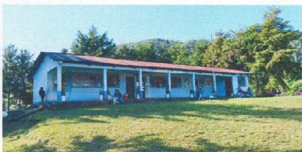
Foto1: Cambio de techo y pintura de la Escuela.
