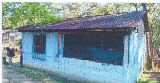
Foto 3: Cambio de techo y colocacion del balcon de la cocina.
