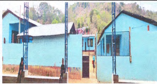
Foto 6: Aplicación de pintura en exteriores de las aulas
