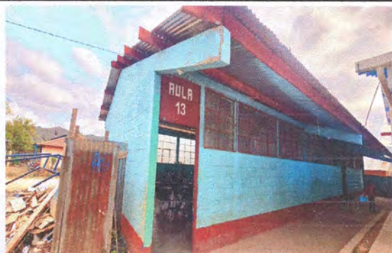
Foto 5: Aplicación de pintura parte exterior de las aulas
