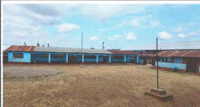
Foto 2: Sustrucción de cubierta de lámina
