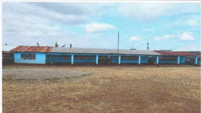
Foto1: Sustrucción de soporte de techo de madera por metal
