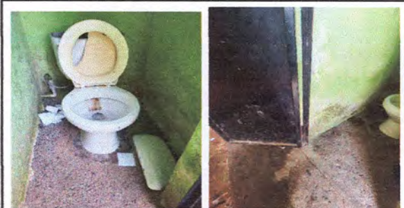
Foto 6: Servicios sanitarios y puertas de metal
