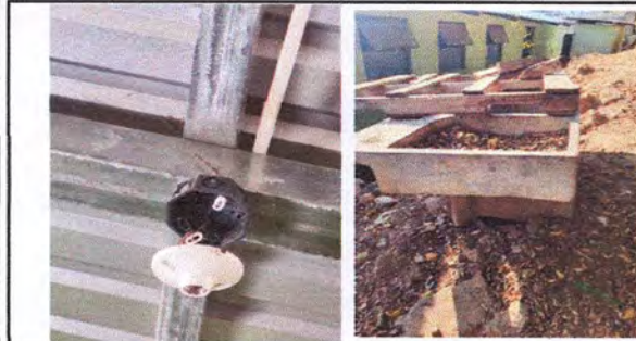
Foto 1: Reparación de sistema eléctrica y Sustitución de pila de cemento de dos lavadoras
