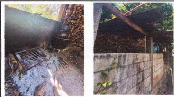
Foto 2: Reparación de cocina
