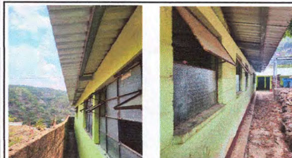
Foto 3: Mantenimiento de balcones de metal y canaletas
