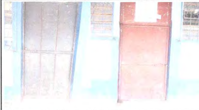
Foto 10: Mantenimiento de puertas de metal
