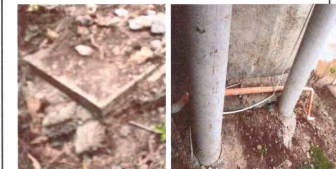
Foto 5: Sustitucion de caja de registro y tubería PVC línea principal aguas negras.
