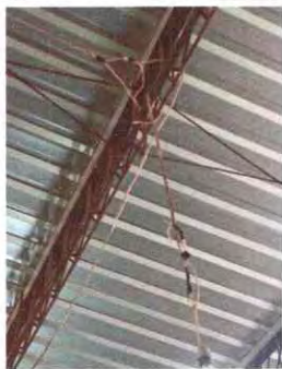
Foto7: Reparación de sistema electrica .
