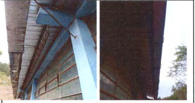
Foto. 4: Sustitucion de canal de metal.
