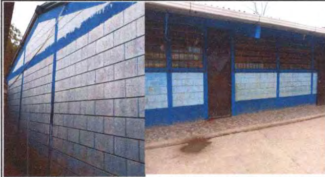
Foto 1: Pintura en paredes exteriores e interiores.
