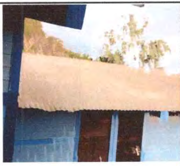
Foto 11: Cubiertas de laminas.
