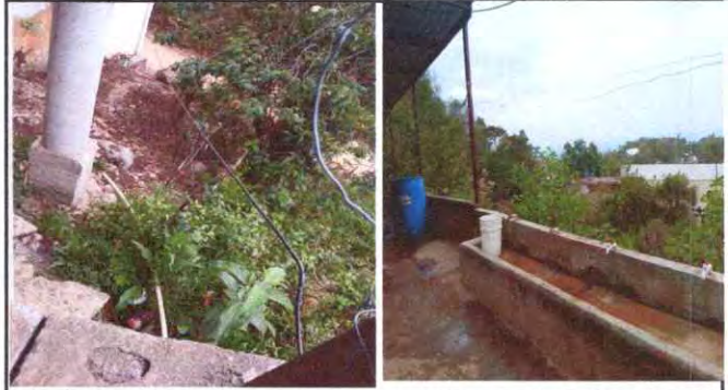
Foto 2 Reparacion de muro perimetral con tubo hg y maya galvanizada.
