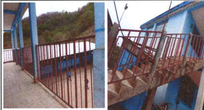
Foto 3: Sustitución debarandas de metal.
