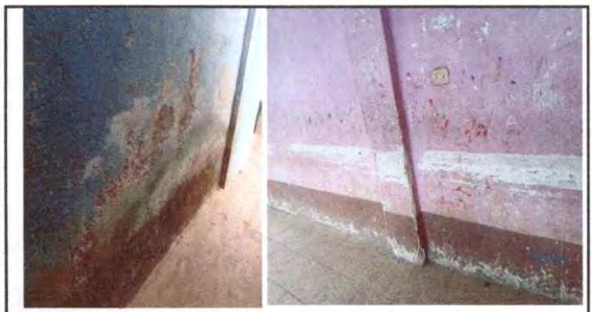
Foto 6 Repello en paredes.
