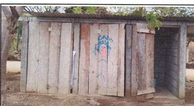
Foto 4: Sustitución de puertas de sanitarios.
