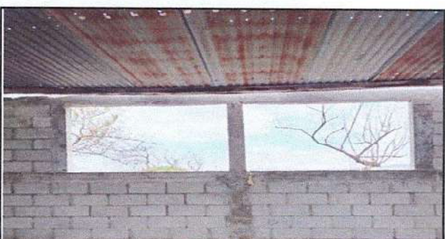
Foto 5: Ventanas de cocina.
