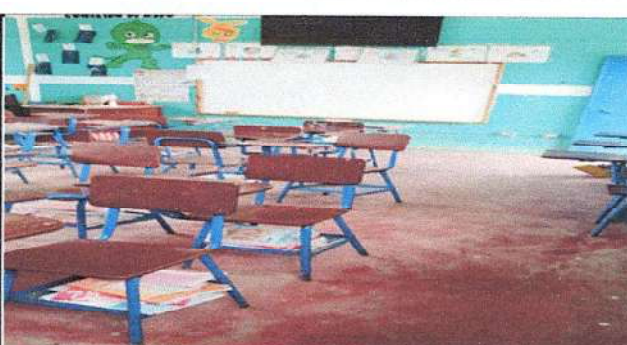
Foto 6: Cambio de piso
