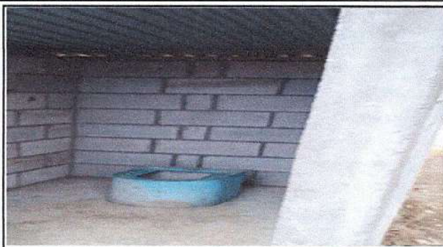
Foto 7: Sustrucción de inodoros y accesorios
