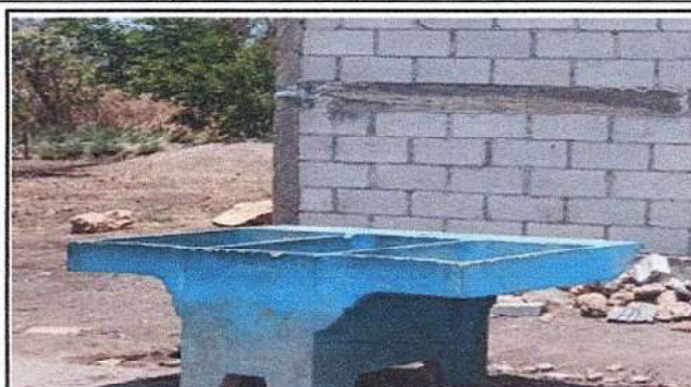
Foto 8: Mejoramiento de red de agua potable
