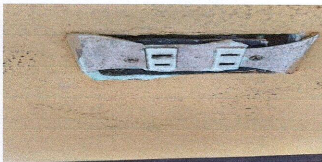
Foto 5: Sustitución de tomacorrientes quebradas
