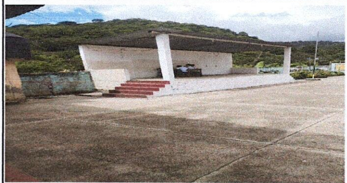
foto 2 : Reparación de muros para repello
