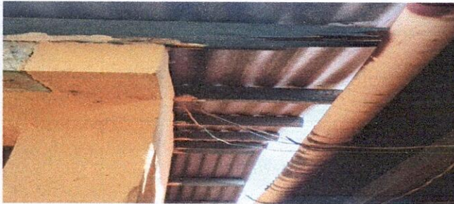
foto 1: Sustitución de estructura de madera a metal.
