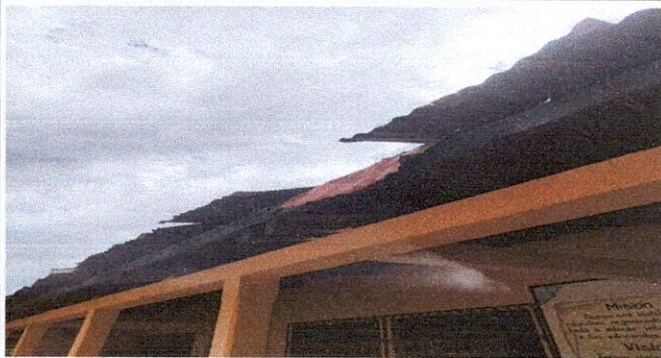
Foto 3: Sustitución de láminas
