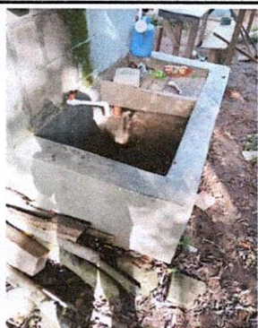
Renglón 13: Sustitución de pila de cemento
