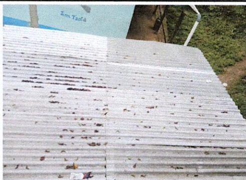
Renglón 15: Sustitución de lámina
