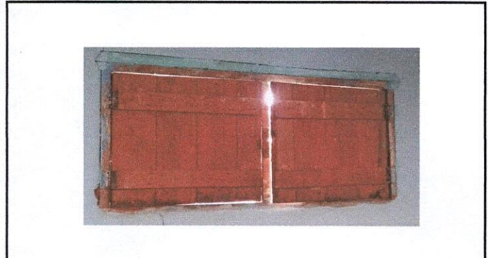
Renglón 2: Sustitución de ventana de madera por metal mas vidrio
