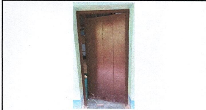
Renglón 1: Sustitución de puertas de madera por metal
