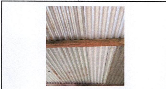
Renglón 3: Sustitución de soporte de madera por metal
