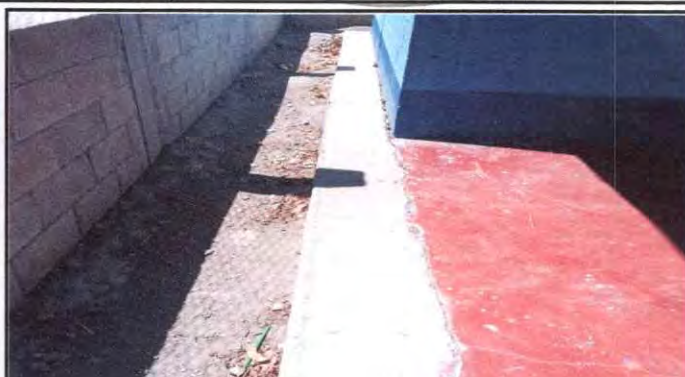
REGLÓN 2 BANQUETAS: SE SUSTITUIRÁ BANQUETA DE CONCRETO EN APROXIMADAMENTE 8 METROS CUADRADOS
