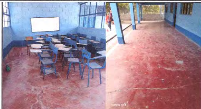
REGLÓN 1 PISOS: EN TRES AMBIENTES DEL CENTRO EDUCATIVO, SE SUSTITUIRÁN APROXIMADAMENTE 157 METROS CUADRADOS DE PISO DE TORTA DE CEMENTO POR PISO DE GRANITO
