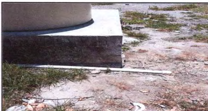
REGLÓN 3 DRENAJES: SE SUSTITUIRÁ TUBO DE PVC DE 4 METROS, CODO Y T EN LÍNEA DE AGUAS NEGRAS DEL MINGITORIO
