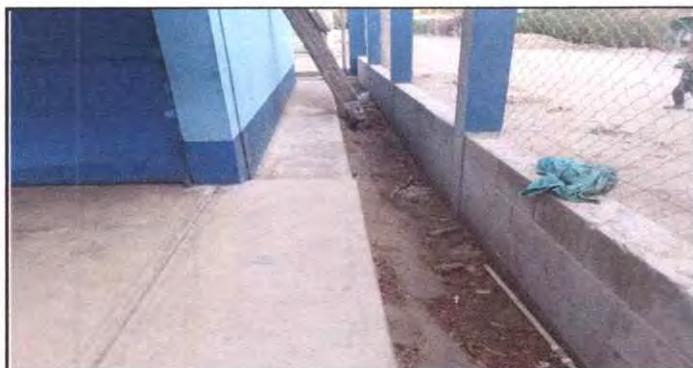
REGLÓN 2 BANQUETAS: SE MEJORARÁ LA BANQUETA EN APROXIMADAMENTE 5 METROS CUADRADOS
