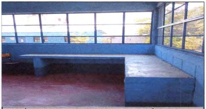
REGLÓN 8 COCINA: A ESTA MESA SE LE COLOCARÁ AZULEJO Y REPELLO
