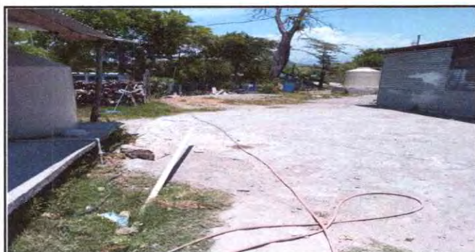
REGLÓN 3 AGUA POTABLE: DE ESTE PUNTO SE COLOCARÁ TUBERÍA DE 1 1/2" PARA ABASTECER DE AGUA A LOS DEPÓSITOS QUE SE COLOCARÁN SOBRE LA TERRAZA DE LOS SERVICIOS SANITARIOS
