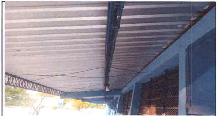
REGLÓN 6 ENERGÍA ELÉCTRICA: SOBRE LA VIGA DEL CENTRO SE INSTALARÁ LA NUEVA LÍNEA DE CABLEADO SÓLIDO NO. 10 DESDE LA CAJA DE FLIPONES HASTA DONDE FINALIZA ESTE EDIFICIO
