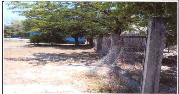
REGLÓN 4 MURO PERIMETRAL: EN LA PARTE NORTE DEL CENTRO EDUCATIVO, SE REPARARÁN 172 M 2 CON MALLA Y TUBO GALVANIZADO DE 2"
