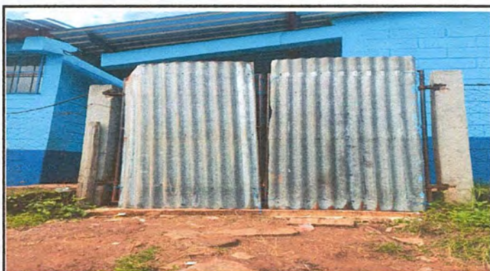
Foto 4: Sustitución de portón de metal.
