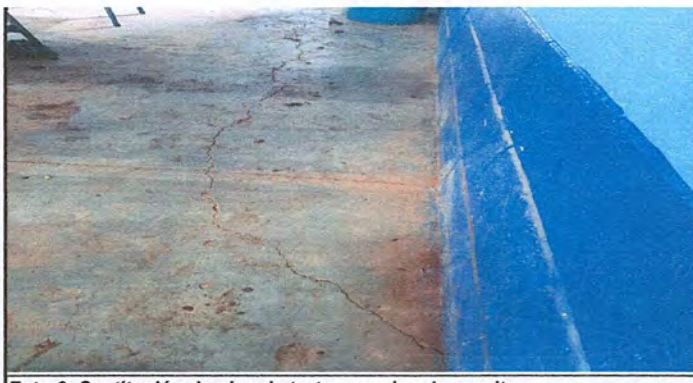
Foto 6: Sustitución de piso de torta, por piso de granito
