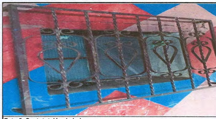
Foto 5: Sustutución de balcones.
