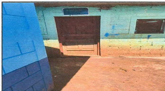
Foto 3: Sustitución de puerta.
