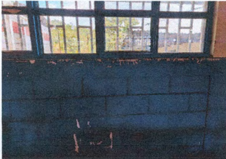
Foto 7: Pintura en muros exteriores e interiores
