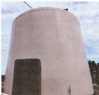
Foto 9: Reparación y mantenimiento de sisternas/ Depósito de agua.
