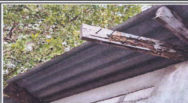
Foto 2: Estructura de techo
