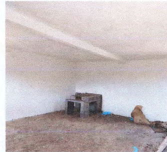
Foto 8: Reparación de sistema eléctrico
