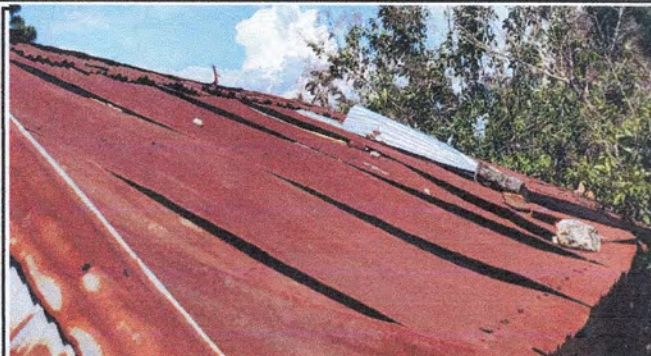
Foto1: Cubierta de lámina
