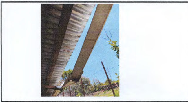
Foto 6: Canales y bajadas de agua pluvial
