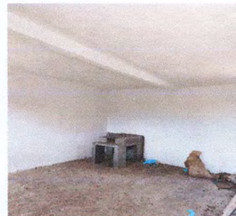
Foto 10: Reparación de cocina
