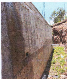
Foto 11: REPARACIÓN DE REPELLO Y CERNIDO DE PAREDES
