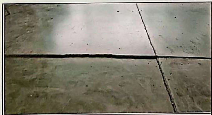
Foto 5: El piso de las aulas se ha agrietado y esto sucede en todas las aulas.
