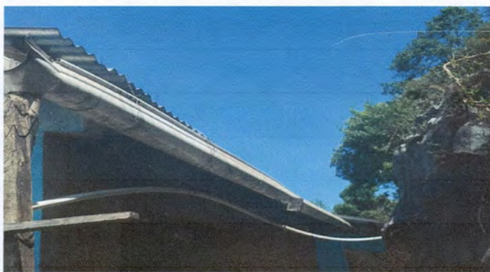
Foto 4: Canales y bajadas de agua pluvial
