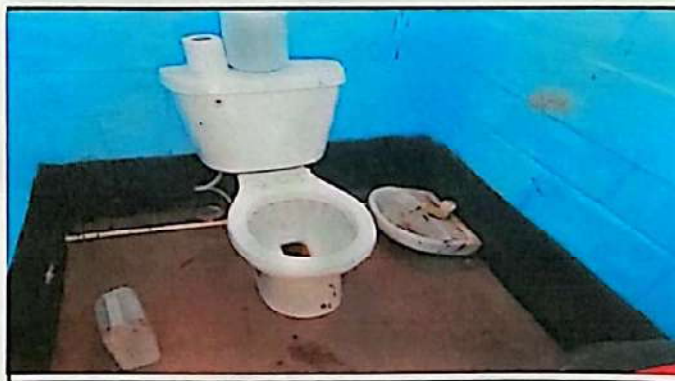
Foto: 6. accesorios deteriorados y lavamanos
