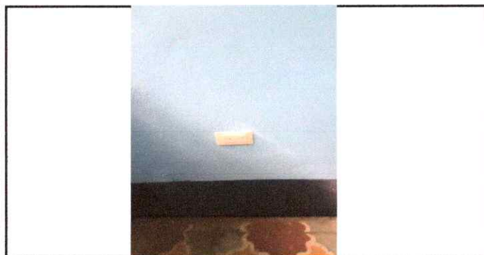
Foto 5: Toma corrientes instalados.
