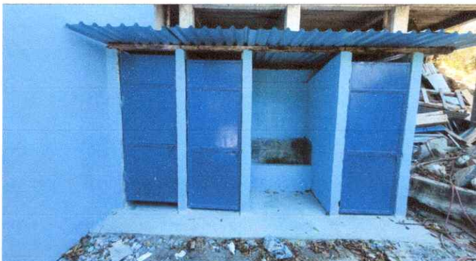
Foto 4: Puertas de metal instaladas.
