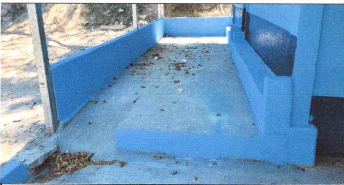
Foto 5: Torta de cemento terminadas.
