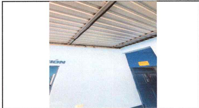
Foto 4: Cableado y accesorios instalados y reparados.
