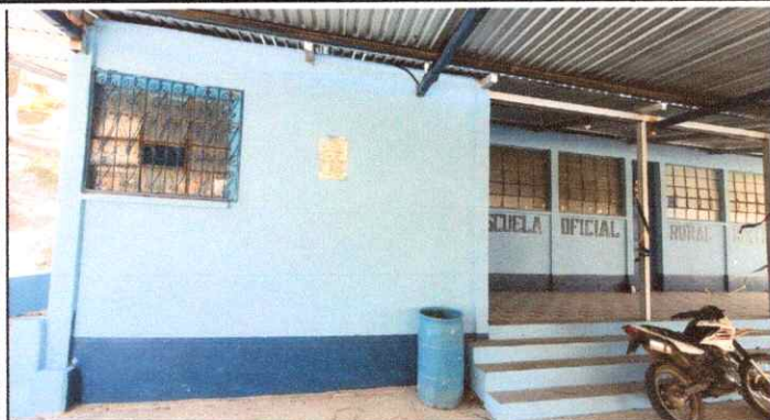
Foto1: Escuela totalmente pintada.
