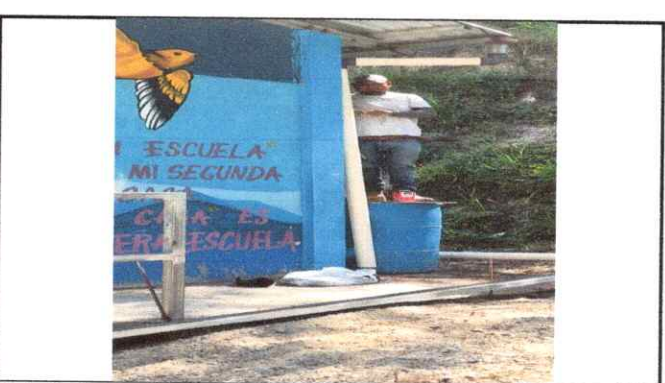
Foto 6: Colocación de tubos para caída de agua pluvial.
