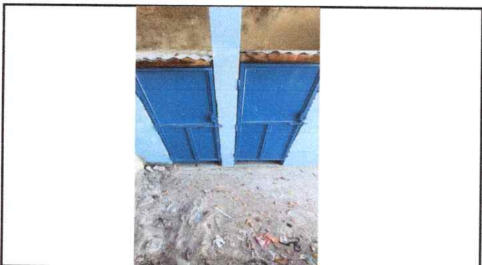
Foto 3: Mantenimiento de puertas de metal.
