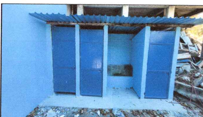
Foto 4: Mantenimiento y cambio de puertas de metal..
