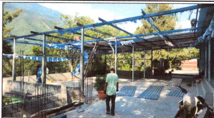
Foto1: Colocación de nueva lámina troquelada.
