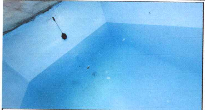
Foto 2: Sisterna por dentro, probando el funcionamiento.
