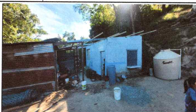
Foto 2: Cambio de soportes de madera por metal y lámina.
