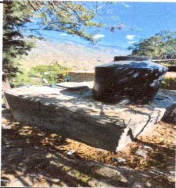
Foto 3: Sisterna repellada por fuera.
