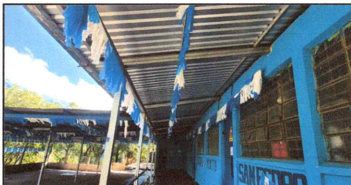
Foto 6: plafoneras, focos e interruptores inexistentes en corredores y aulas.
