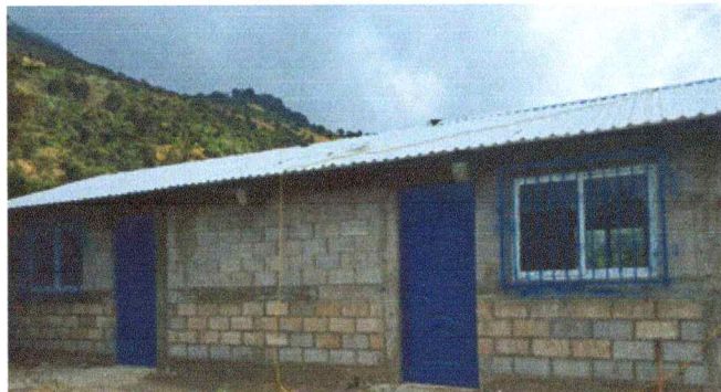
Foto1: Lámina colocada
