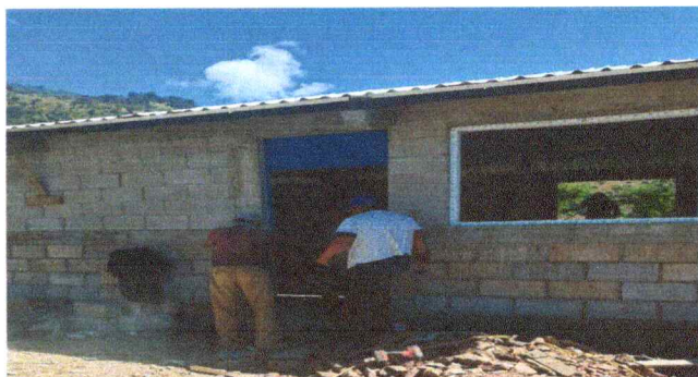
Foto 3: Colocación de puerta
