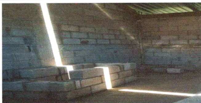
Foto 6: Construcción de fogon
