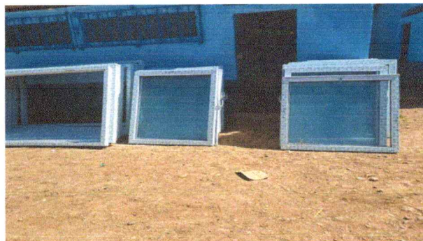
Foto 4: Sustitución de ventanas
