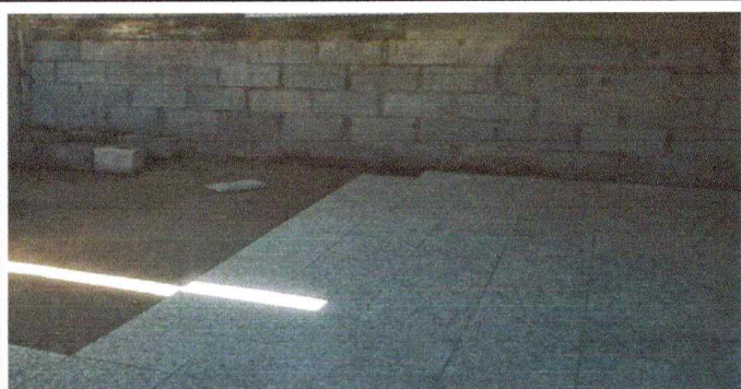
Foto 5: Colocón de piso
