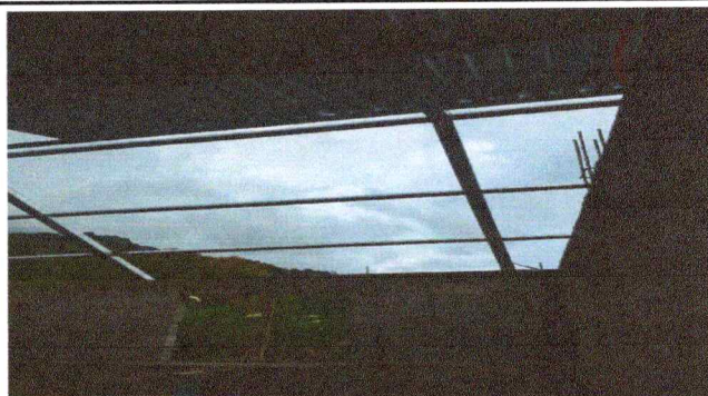
Foto 2: Sustitución de soporte
