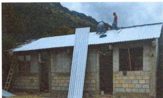
Foto1: Colocación de lámina
