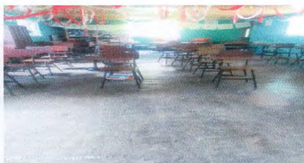
Foto 3: SUSTITUCION DE PISO DE GRANITO
