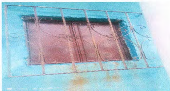
Foto 5: SUSTITUCION DE VENTANAS
