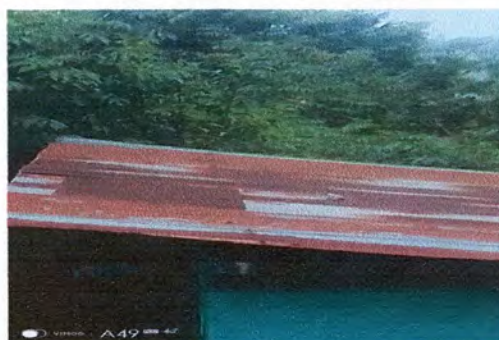
Foto 4: SUSTITUCION DE LAMINA TROQUELADA
