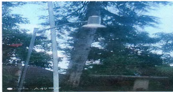
Foto 6: SUSTITUCION DE LAMPARAS
