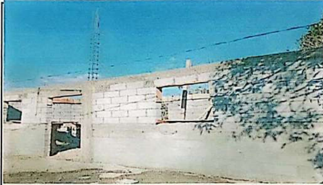
Foto 7: Sustrucción de ventanas.
