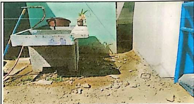
Foto14: Mejoramiento de red de drenaje, línea principal aguas negras .
