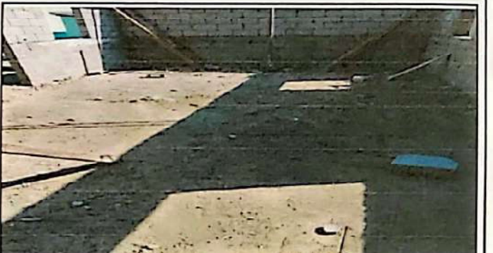
Foto 12 : Mejoramiento de piso de granito.
