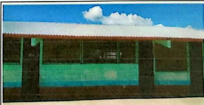
Foto 6: Mejoramiento de piso granito.
