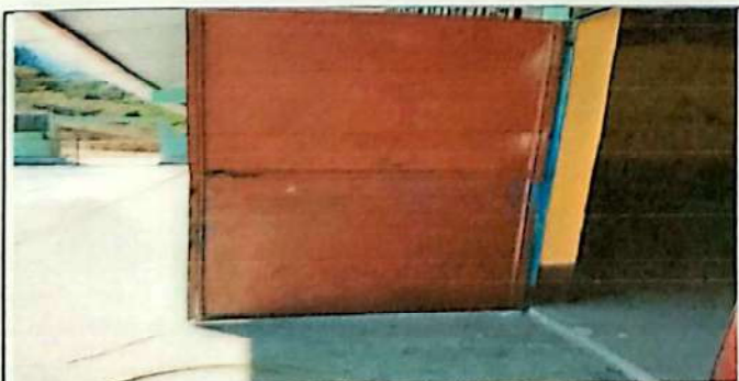
Foto 5: Sustitución de puertas.
