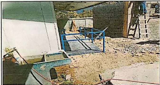
Foto15: Mejoramiento de red de agua potable.
