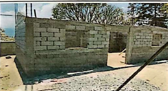
Foto 11: Mejoramiento de piso de torta de concreto.
