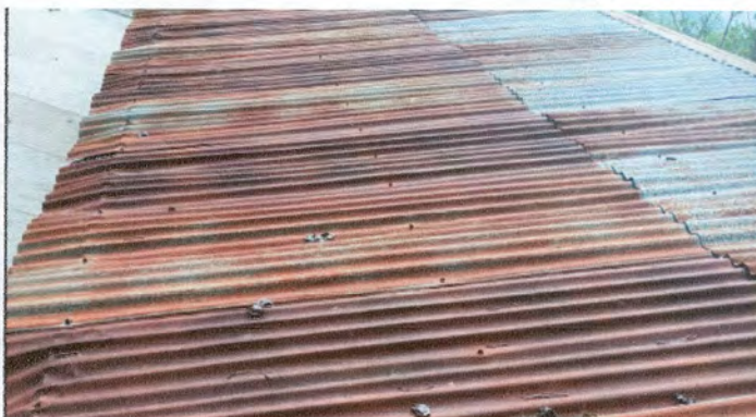
Foto 3: Lámina deteriorada
