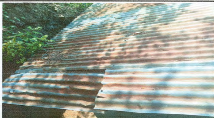
Foto 2: Lámina deteriorada
