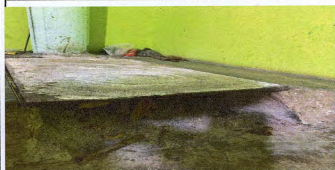
Foto 5: Sustitucion de plancha de metal de 3 hornillas
