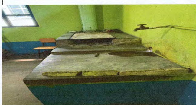
Foto 4: Instalacion de azulejos en la estufa rural
