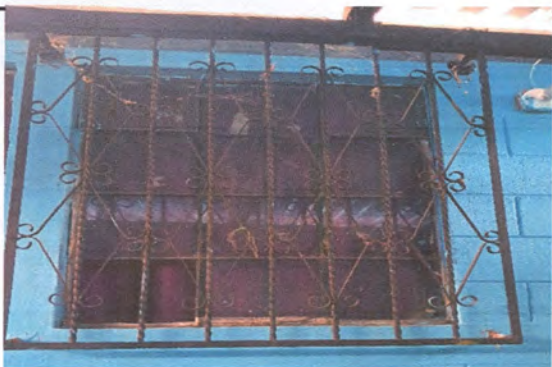
Foto 3: Sustitución de ventanas
