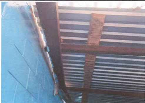
Foto 5: Sustitución de estructura portante de madera por metalica
