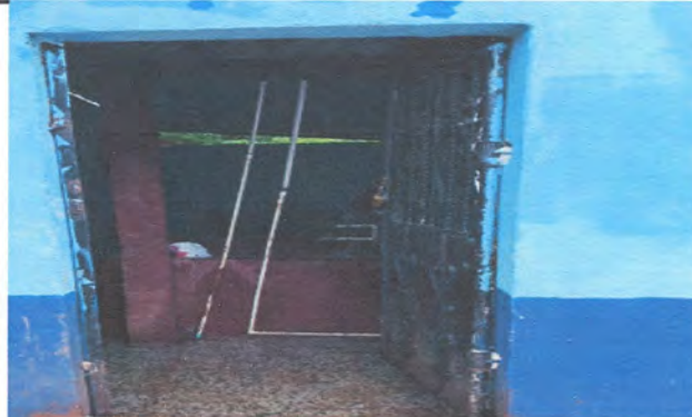
Foto 2: Sustitución de portones
