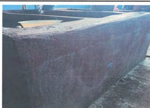
Foto 6: Sustitucion de pila de cemento
