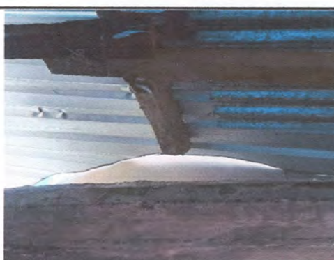
Foto 4: Sustitucion de lamina por lamina troquelada aluzinc calibre 26
