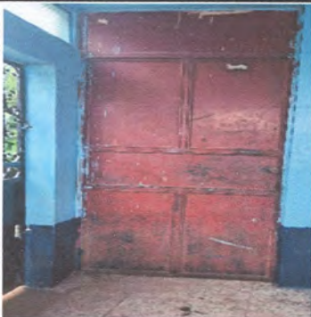
Foto1: Sustitucion de puertas de metal
