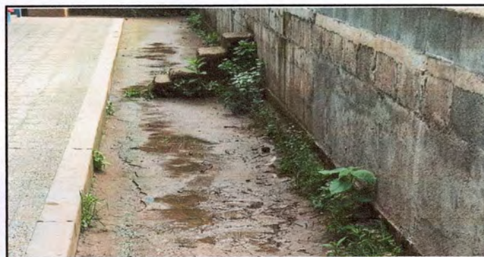
Foto 5: Cuneta deteriorada
