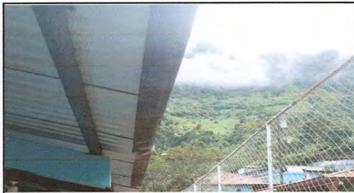
Foto 4: Canales y bajadas de agua
