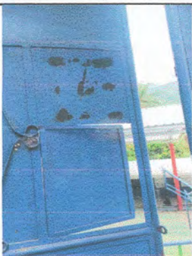
Foto 1: Mantenimiento a portones de metal (Lijado y pintado)
