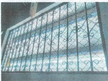
Foto 9: Sustitución de estructura de metal mas vidrio
