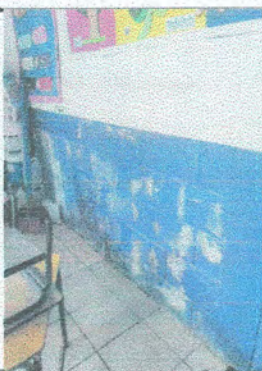
Foto 11: Pintura en muros exteriores e interiores
