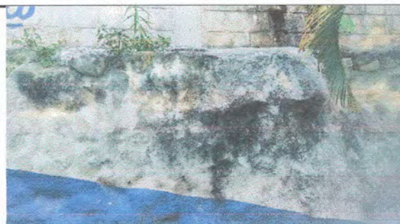
Foto 4: Pintura en muros exteriores e interiores
