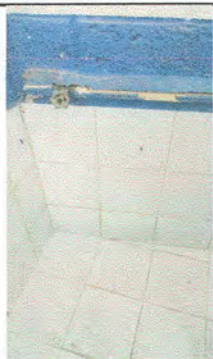
Foto 5: Sustitución de accesorios en inodoros
