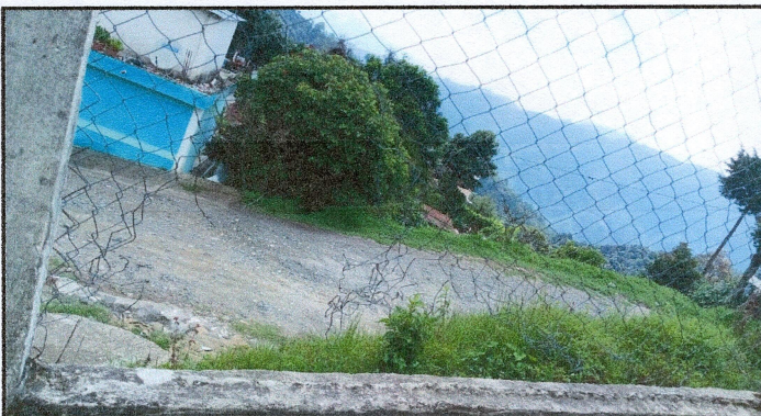
Foto 3: Estructura de techo en mal estado
