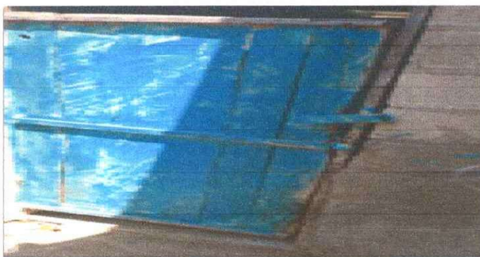
Foto 5: Sustitución de puertas metalicas
