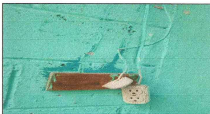
Foto 6: Reparación de cableado electrónico
