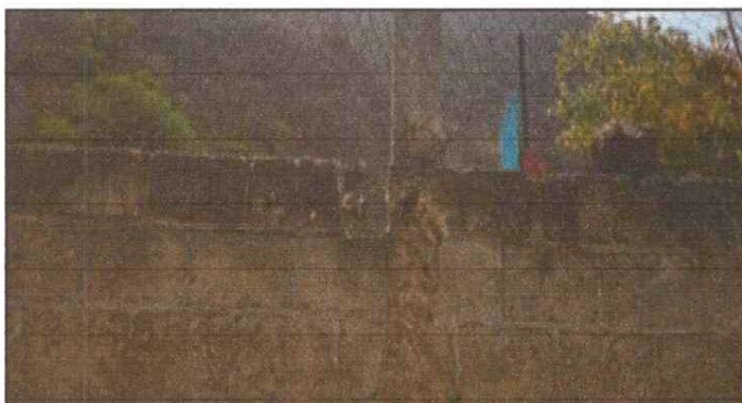
Foto 3: Reparación de muro perimetral de block
