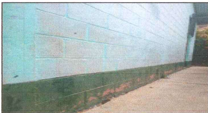
Foto 1: Pintura deteriorada
