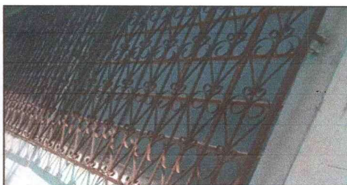
Foto 6: Mantenimiento de balcones de metal
