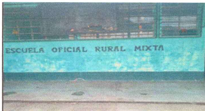
Foto 2: Sustitución de pintura
