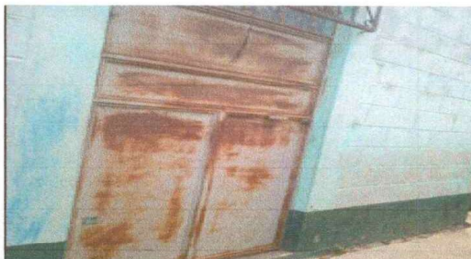
Foto 4: Mantenimiento de puertas metales
