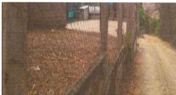
Foto 4: Sustitución de malla galvanizada
