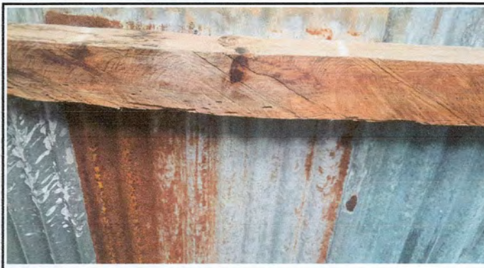
Foto 2: Sustitucion de soporte de madera por metal
