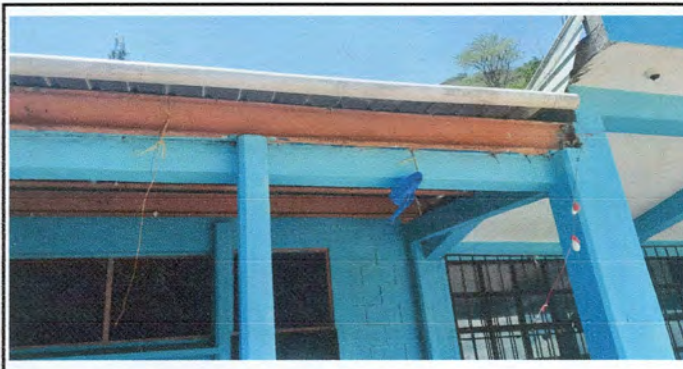
Foto 4: Sustitución de canal de pvc por metal
