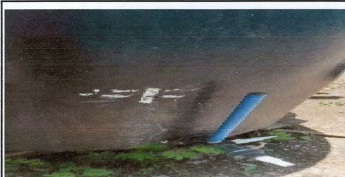
Foto 6: Depósito de agua quebrado en mal estado
