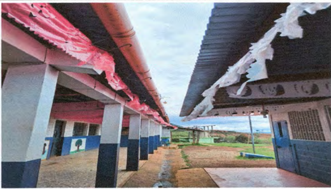
Foto 4: Canales y bajadas de agua pluvial
