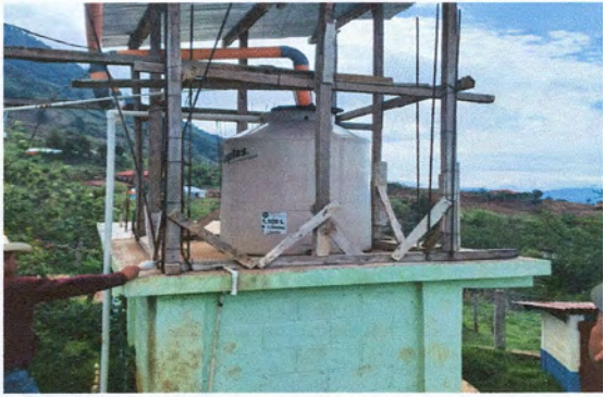
Foto 8: Reparación y mantenimiento de sisterna (rotoplas)
