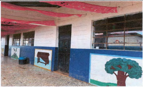
Foto 5: Pintura en muros exteriores e interiores
