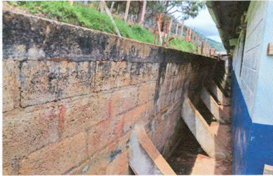
Foto 10: Reparación de muro de contención
