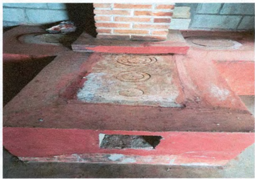
Foto 9: Reparación de cocina (plancha)
