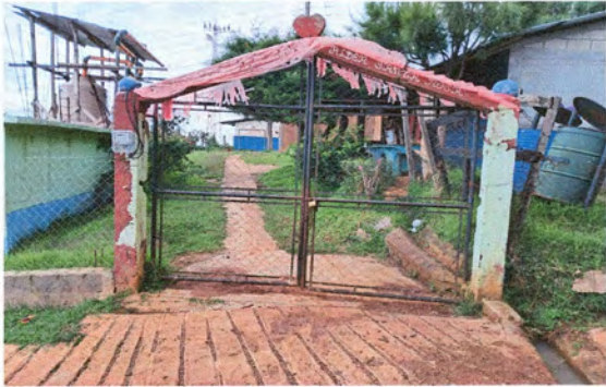
Foto 6: Mantenimiento a portón
