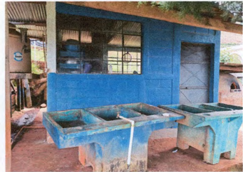
Foto 11: Reparación de pila
