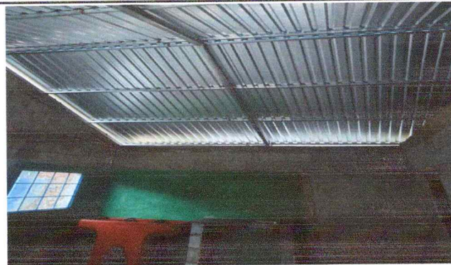
Foto 2: Estructura de techo
