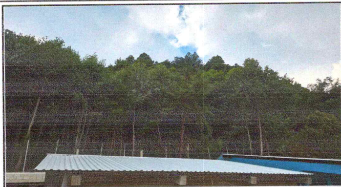
Foto1: Cubierta de Lámina
