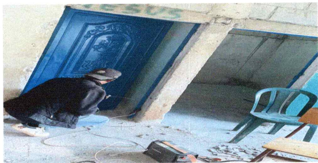
Foto 3: Proceso de inslación de puerta de metal
