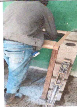
Foto 8: Proceso de instalación de lavatrastos
