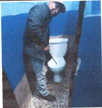
Foto7: Proceso de instalación de inodoro
