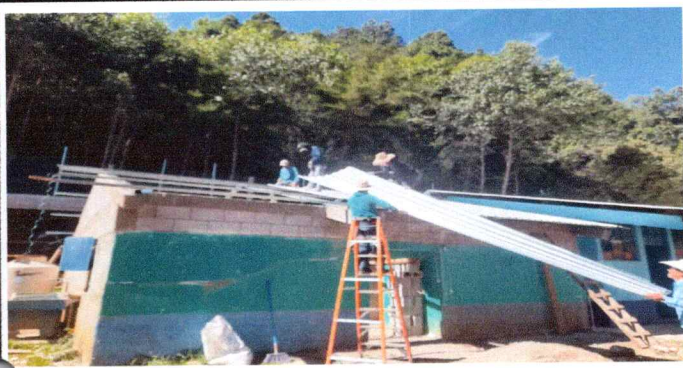
Foto 1: Proceso de inslación de lámina.
