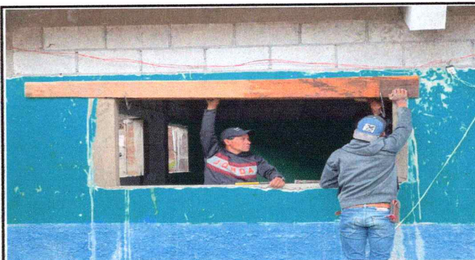
Foto 4: Proceso de inslación de ventana
