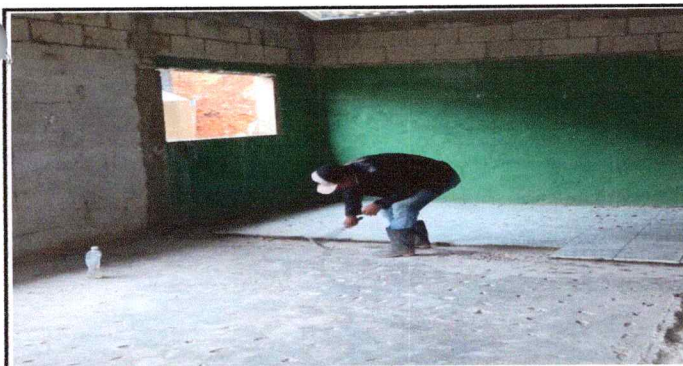
Foto 5: Proceso de colocación de piso
