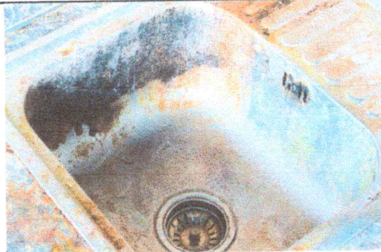
Foto 8: Lavatrastos deteriorado.
