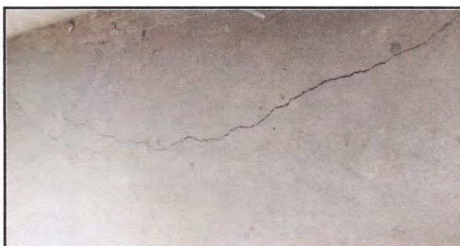
FOTO 6: SUSTITUCIÓN DE PISO AGRIETADO.
