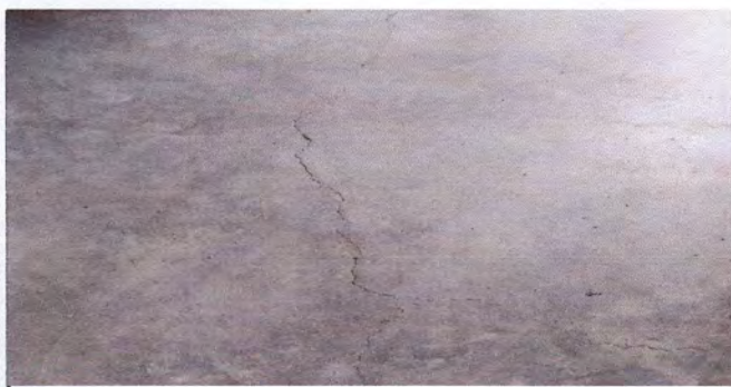
FOTO 5: SUSTITUCIÓN DE PISO EN MAL ESTADO
