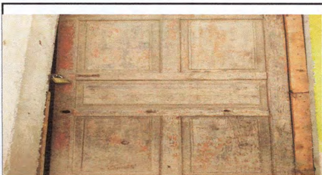
FOTO 3: SUSTITUCIÓN DE PUERTA.
