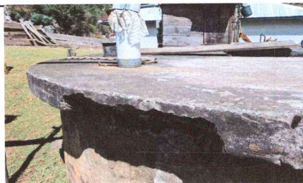
Foto 6: Sisterna deteriorada
