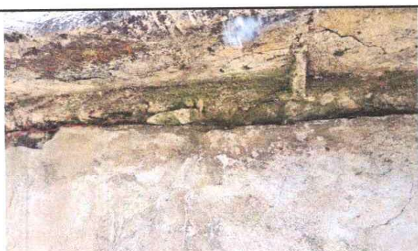
Foto 5: Sisterna deteriorada
