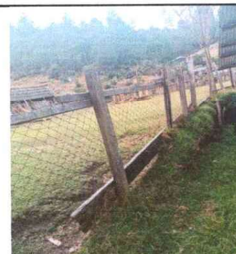
Foto 4: Circulación en malas condiciones.
