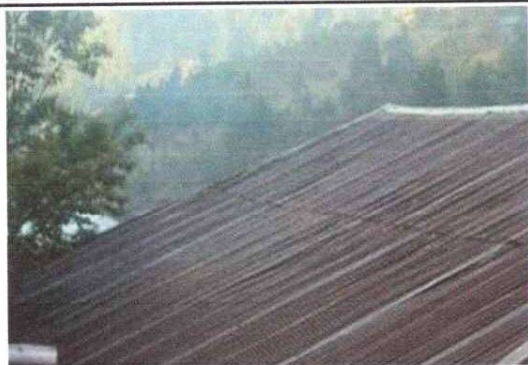
Foto1: Lámina deteriorada
