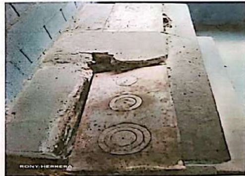
Foto 4: Fogon en malas condiciones.
