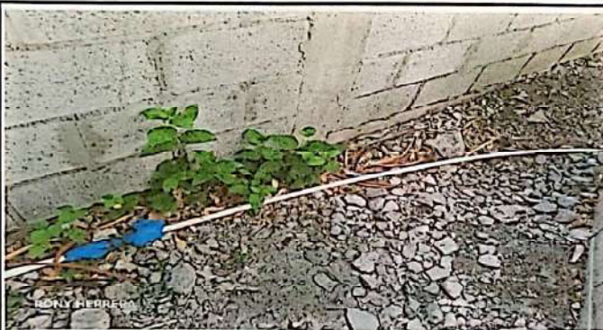
Foto 3: Sustitución de accesorio de red de agua en sanitarios.
