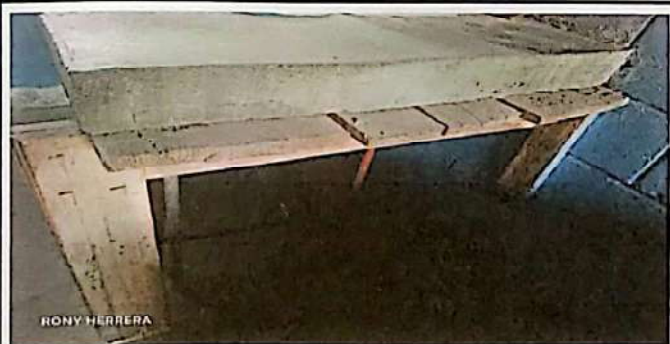
Foto 5: Mejoramiento de muebles de cocina.
