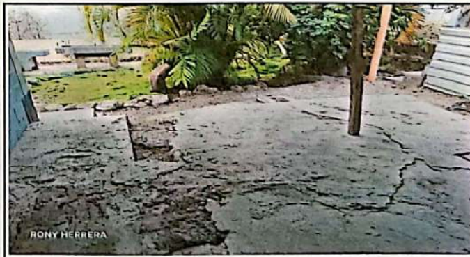
Foto 6: Reraparcion de piso de torta de concreto.
