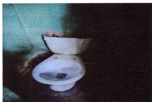
Foto 5: Sustrucción de 3 inodoros
