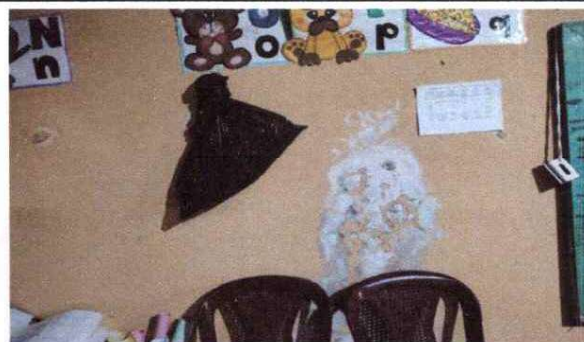
Foto 4: Aplicación de pintura interior.
