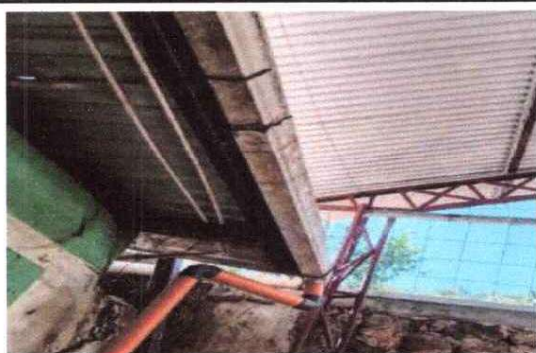
Foto 3: Sustrucción de canales y bajadas de agua pluvial.
