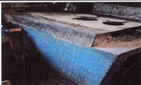
Foto 7: Sustitución de estufa rural completa.
