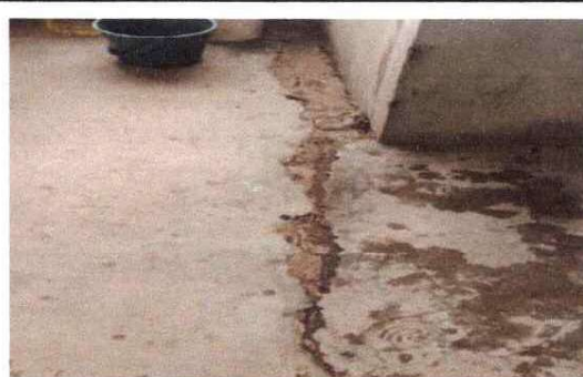
Foto 2: Sustrucción de piso de granito.
