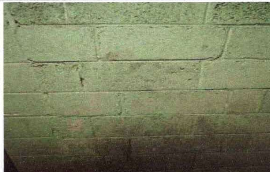
Foto 8: Aplicación de repello en paredes de servicios sanitarios.
