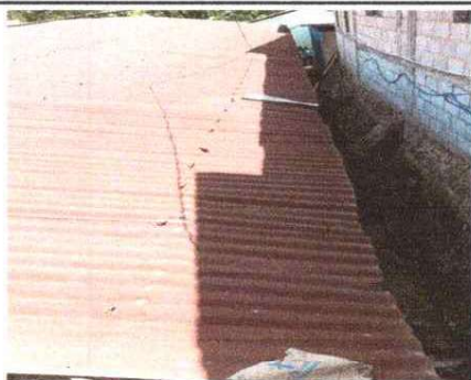
Foto1: Sustitución de techo.
