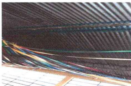
Foto 5: Sustitución de estructura de techo.
