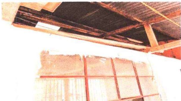
Foto 7: reparación de cableado eléctrico
