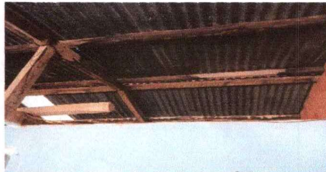
Foto 2: sustitución de estructura de madera por metal
