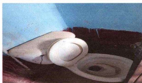
Foto 4: Sustitución de inodoros
