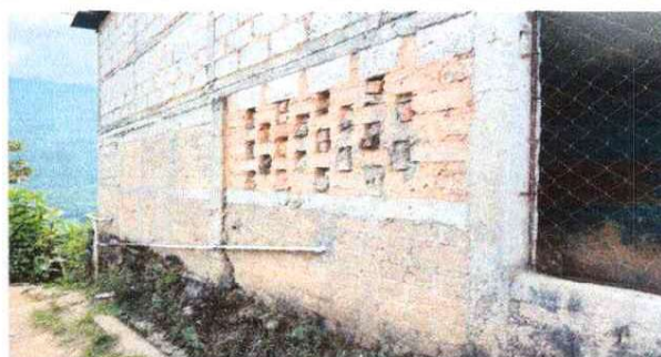
Foto 6: Sustitución de tubos de drenaje
