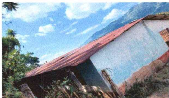
Foto1: Sustitución de techo
