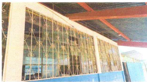
Foto 4: Sustrucion de ventanas
