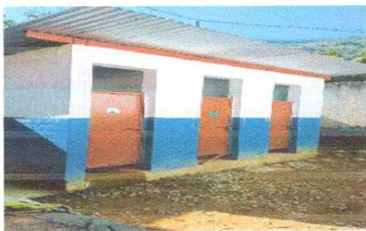
Foto 3: Sustrucion de puertas de inodoro
