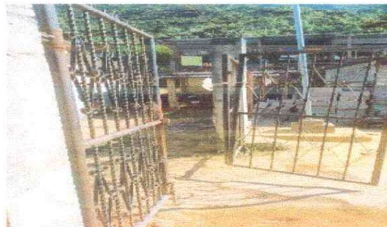
Foto 2: sustitucion de porton
