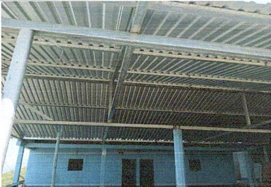
Foto 2: Estructura de techo nuevo.
