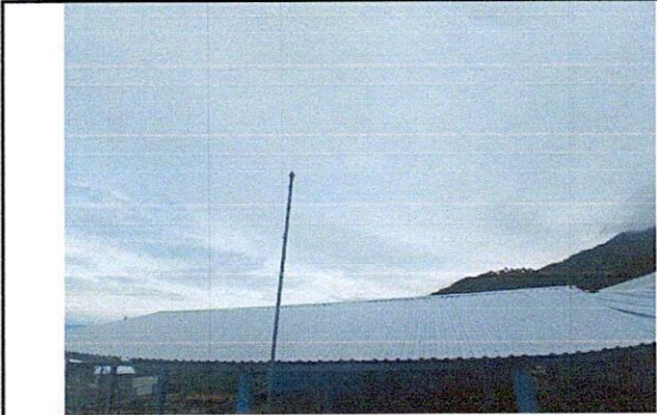
Foto1: Láminas nuevas colocadas.
