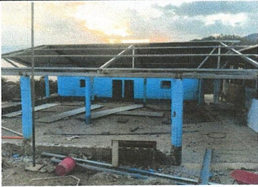
Foto1: Colocación de láminas.
