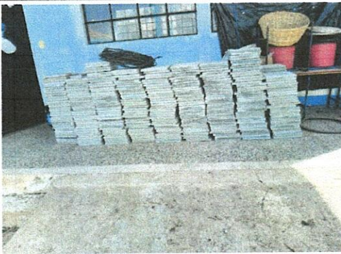
Foto 3: Avance en la colocación de piso.
