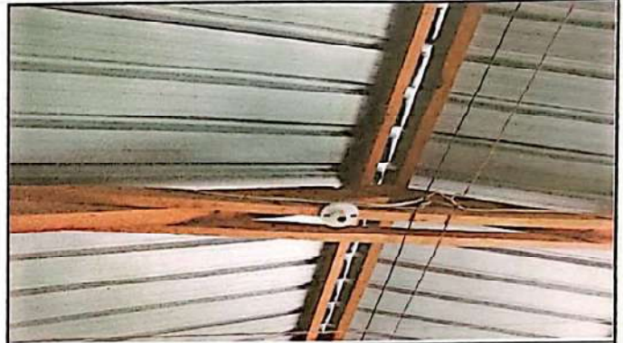
Foto 8: Sistema eléctrico en malas condiciones
